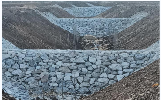
居日很扎拉嘎项目区谷坊+沟底造林
