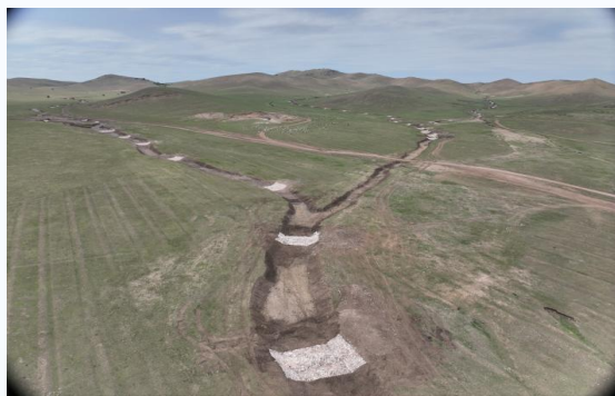
扎赉特旗巴音套海小流域谷坊工程
