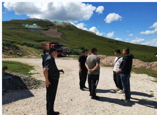
生产建设项目现场督查检查
