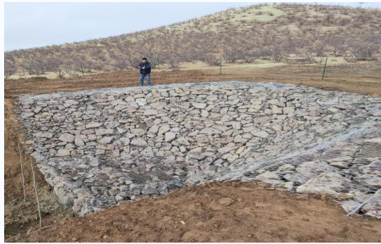
科右中旗雅玛图小流域沟头防护工程
