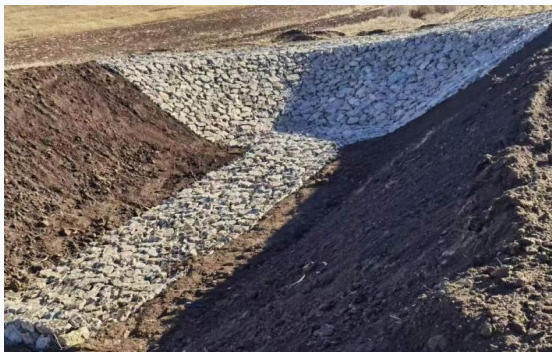
巴彦套海、双榆树项目区沟头防护工程
