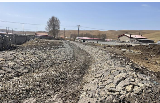
突泉县大保小流域护岸工程
