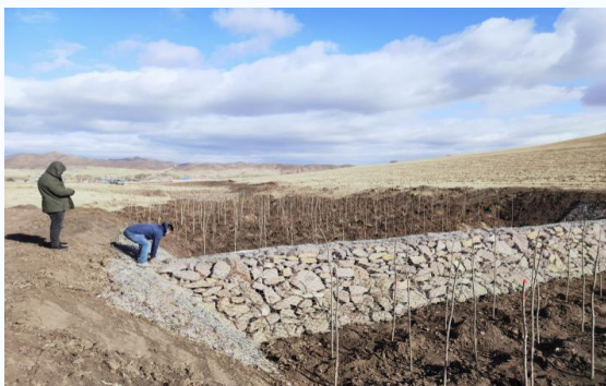
科右中旗雅玛图小流域谷坊工程+沟底造林
