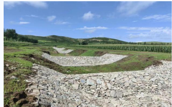
突泉县东平小流域谷坊工程
