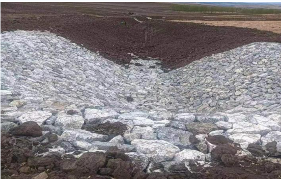
居日很扎拉嘎项目区沟头防护工程
