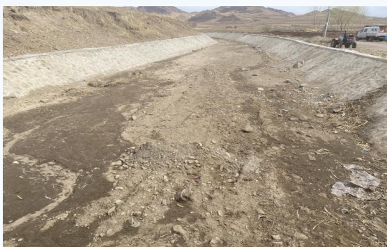
科右前旗光明小流域护岸工程
