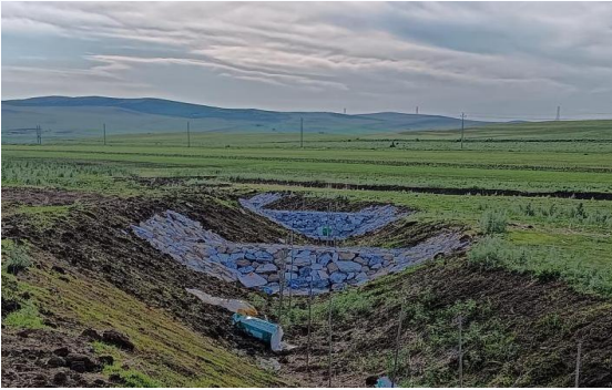
居日很扎拉嘎项目区谷坊+沟底造林
