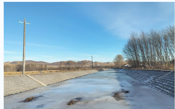
突泉县东平小流域护岸工程
