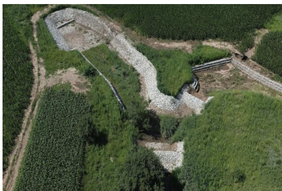
科右中旗沟头防护+护岸工程
