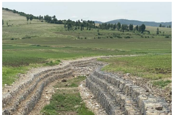
突泉县铅丝石笼挡墙工程
