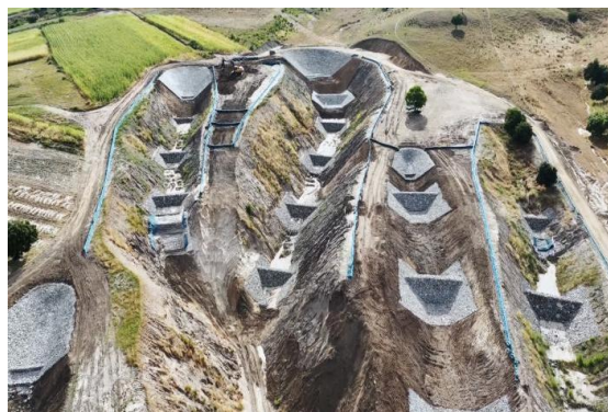
科右中旗沟头防护+谷坊+沟边埂工程
