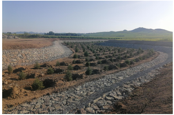
突泉县铅丝石笼护坡+沟底造林工程
