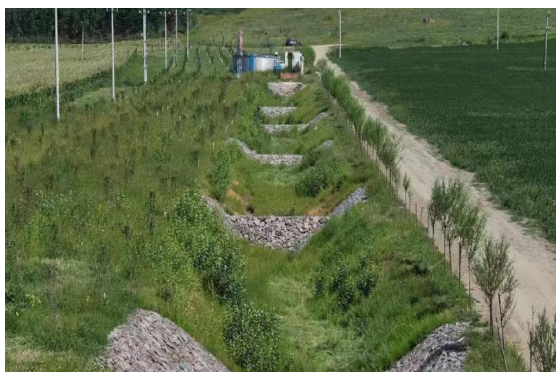
科右前旗铅丝石笼谷坊工程
