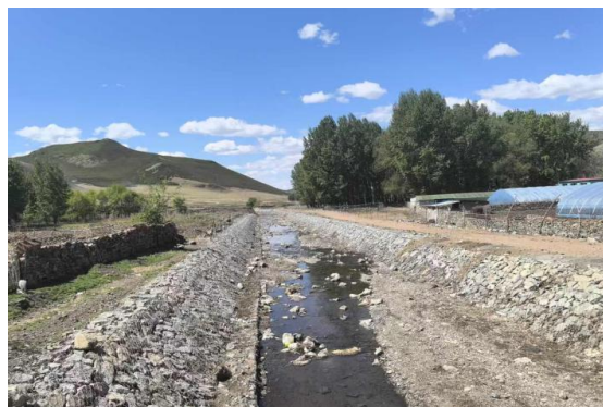
突泉县东沟小流域沟岸护砌工程
