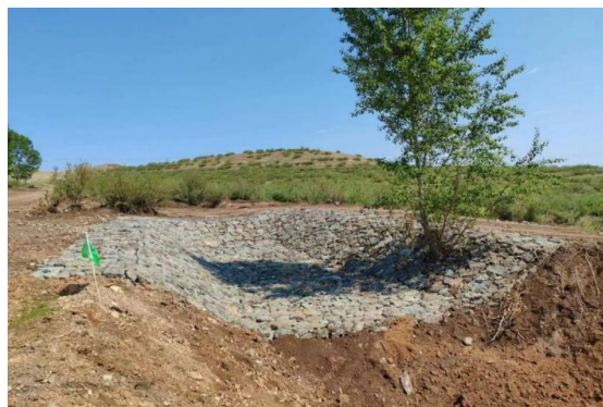
科右前旗铅丝石笼沟头防护工程
