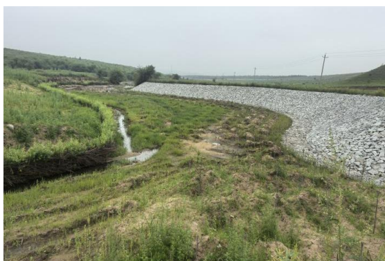
科右中旗柳排护岸+铅丝石笼护岸工程
