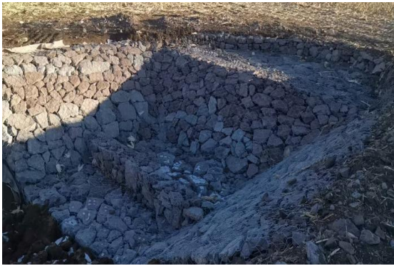
突泉县重力式铅丝石笼沟头防护工程
