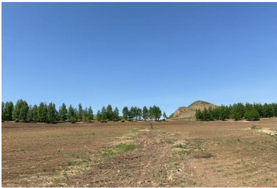
突泉县沟道填埋工程
