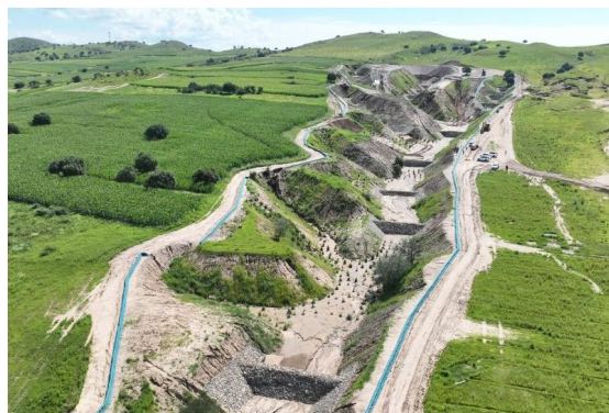
科右中旗沟头防护+谷坊+沟边埂+沟底造林工程
