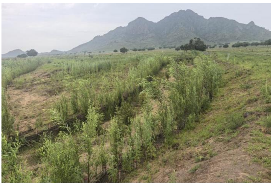
科右中旗柳排护岸工程
