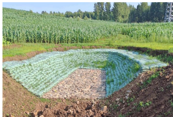
科右前旗生态袋沟头防护工程
