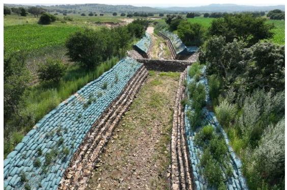
科右中旗铅丝石笼挡墙生态袋护岸工程
