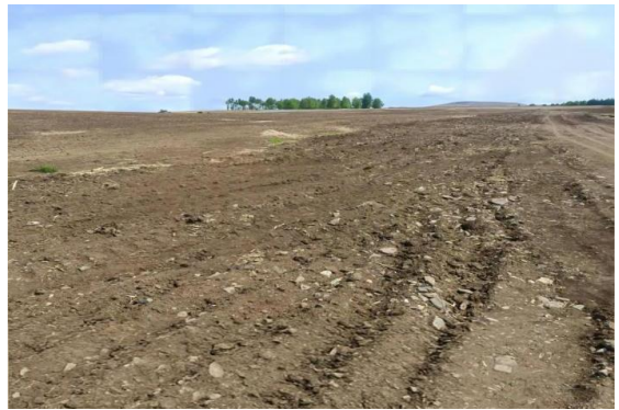
科右前旗沟道填埋复垦工程
