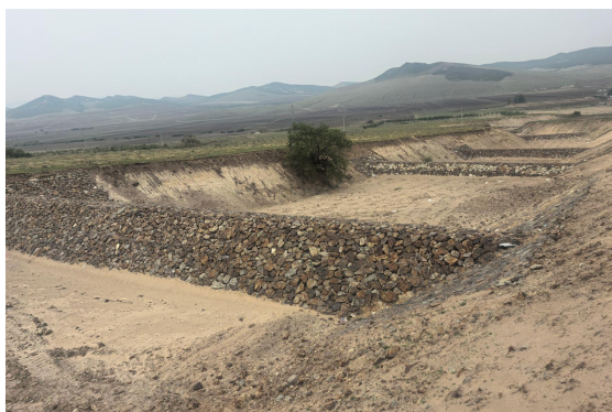
科右中旗索根小流域谷坊工程
