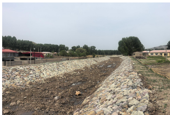
科右中旗农场三队小流域排洪渠工程
