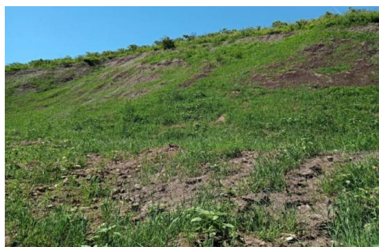
阿尔山市明水河镇小流域裸岩治理工程
