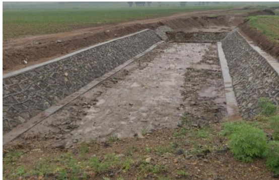
突泉县三个工程区沟岸护砌工程
