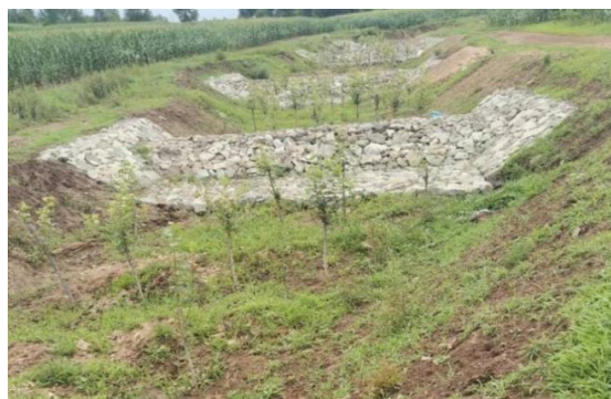
乌兰浩特市马家沟和平项目区沟道治理
