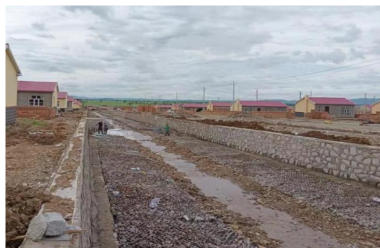
扎赉特旗巴彦乌兰流域山洪沟治理工程
