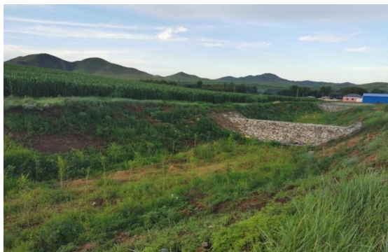
科右中旗拉拉屯项目区谷坊及沟底造林
