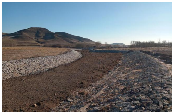
科右中旗拉拉屯项目区沟岸护砌工程
