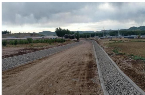
突泉县河东小流域沟岸护砌工程
