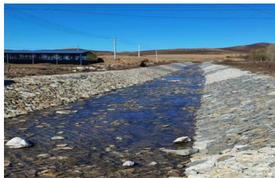
扎赉特旗新合小流域山洪沟治理工程
